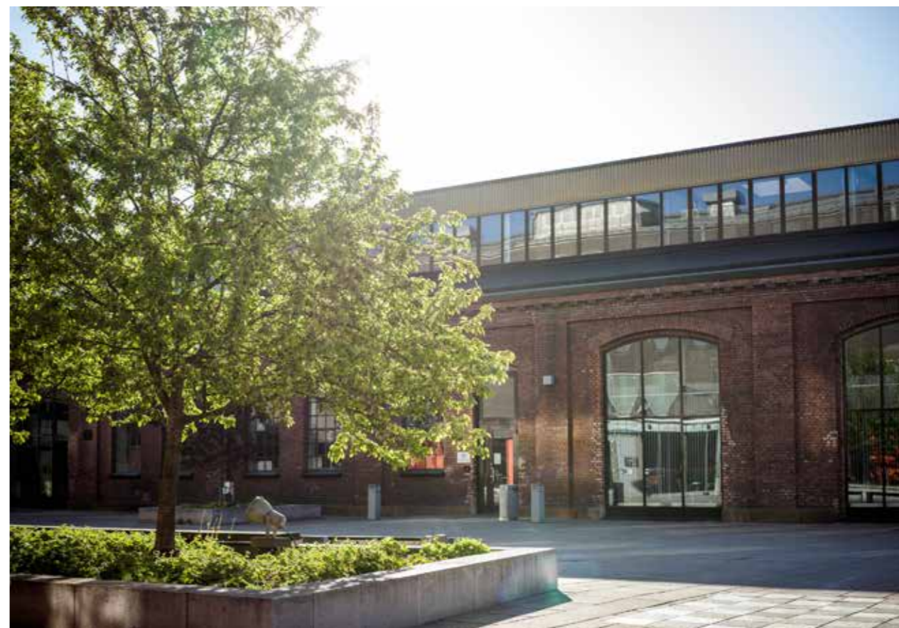
Sundland, bygg C - foto Knut Neerland
