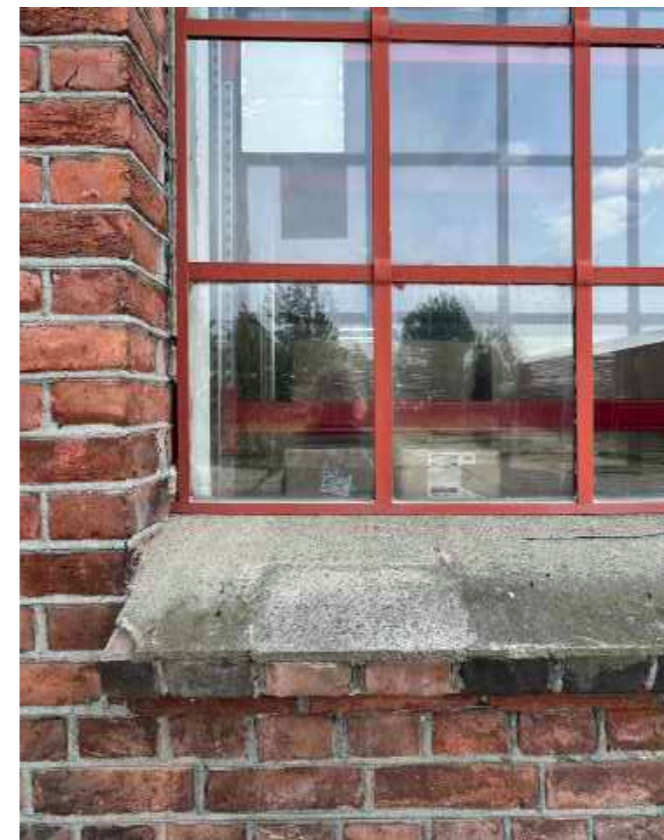
Sålbenk i murt teglstein med pusset overflate
