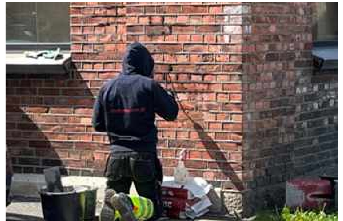
Utbedring av fuger – juni 2023
