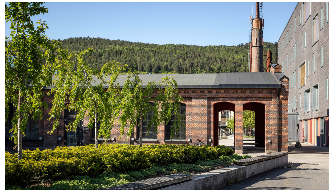
Sundland, bygg C - foto Knut Neerland
