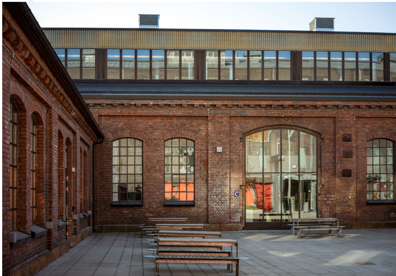
Sundland, bygg C - foto Knut Neerland
