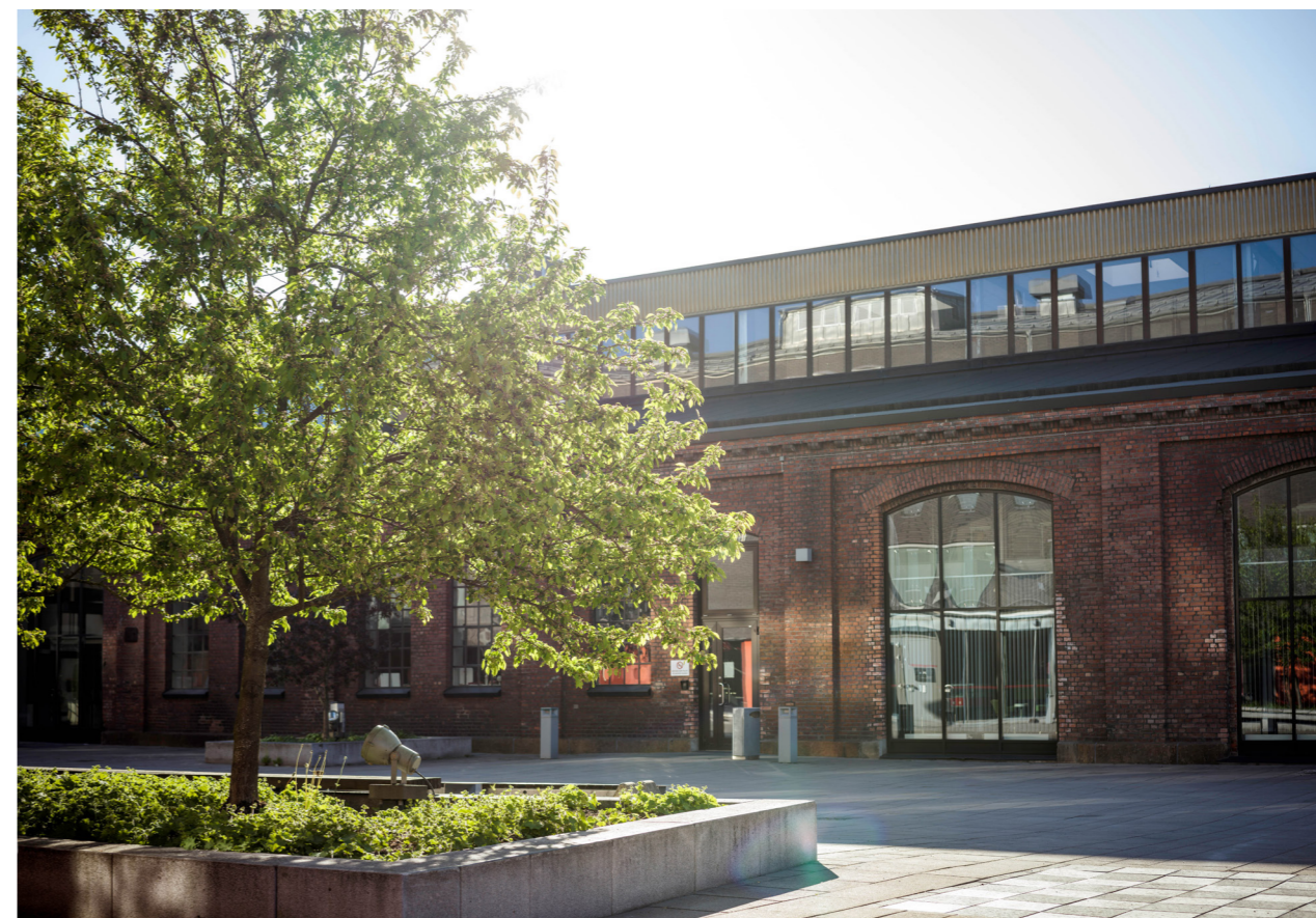
Sundland, bygg C - foto Knut Neerland
