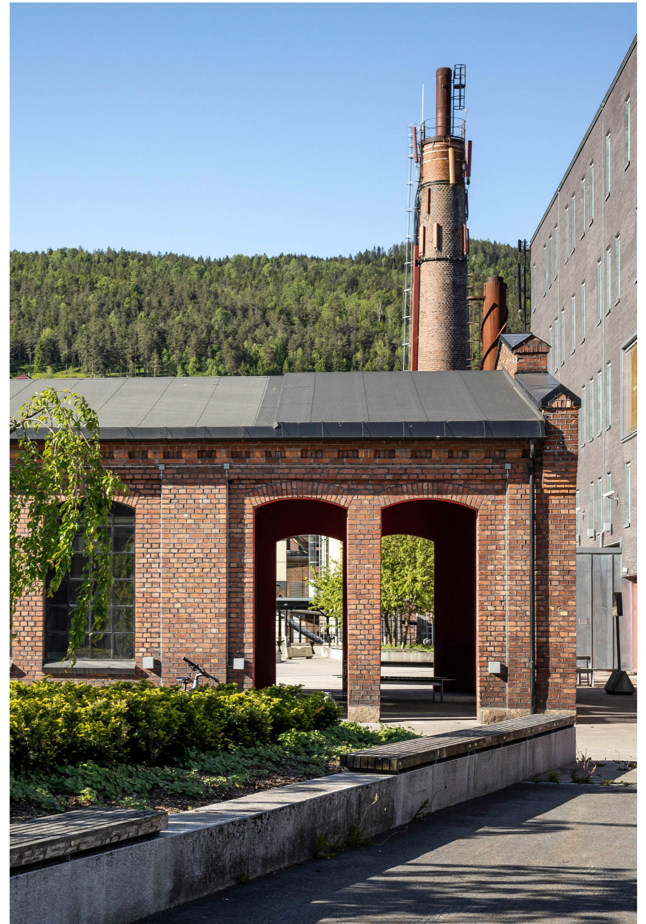
Sundland, bygg C - foto Knut Neerland
